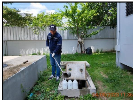
บ่อฟักน้ำทิ้งหลังออกจากระบบบำบัดน้ำเสียรวม
